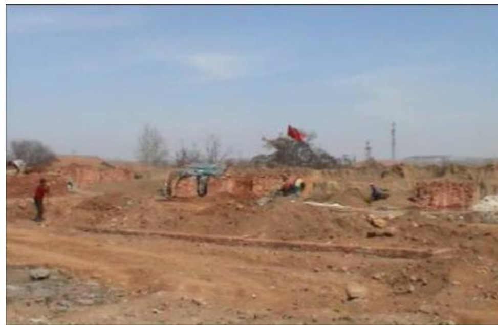
第一座加油站迁坟 清明节破土动工
